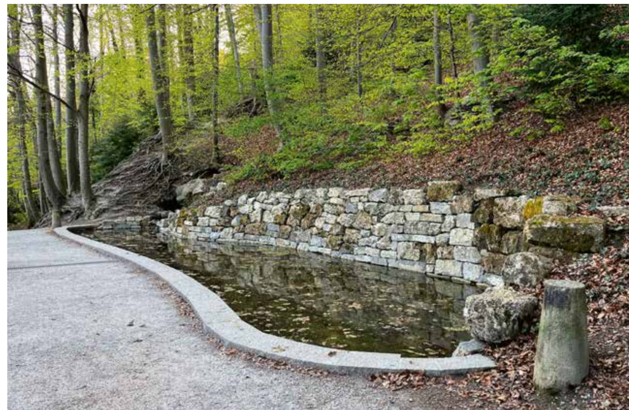
Das Einbringen des Betonbodens des Teichs war wegen der langen Transportwege für das Material aufwendig. Der gestufte Boden dient der Sicherheit für die Menschen. Für Kleinsäuger und Frösche sind Rampen als Ausstiege seitlich im Beckenrand eingelassen.
