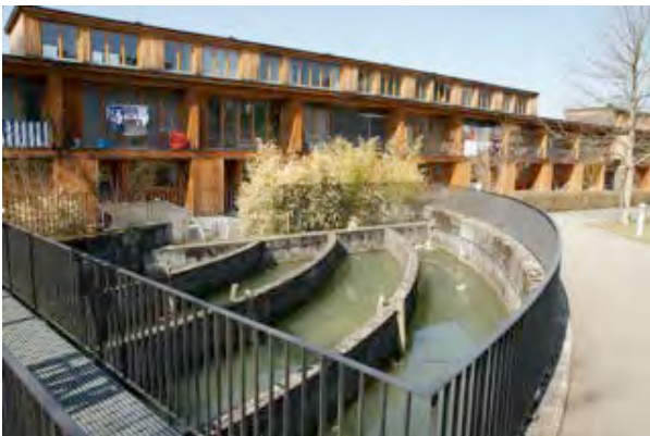
9) Ehemaliges Einlaufbauwerk der Schappe-Spinnerei (Arlesheim) Foto Archiv SL
