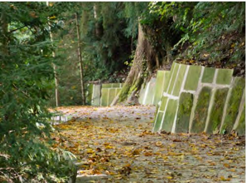
Sandsteinmauern stützen den Hang. Des murs en grès retiennent la pente.
